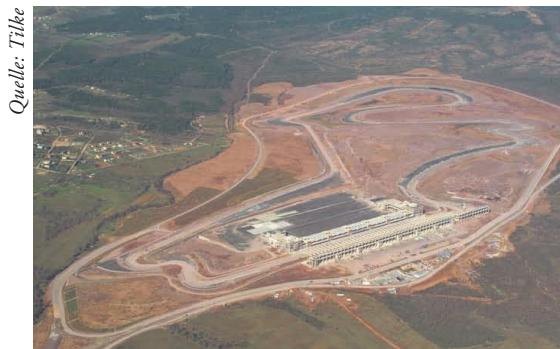
Abb. 1: Baustelle des Istanbul Autodrom Circuit
