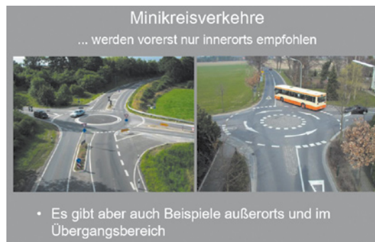
Abb. 6: Beispiele von Minikreisverkehren (Quelle: Dr.-Ing. Wolfgang Haller/Ingenieurgesellschaft Schnüll Haller und Partner, Hannover)
