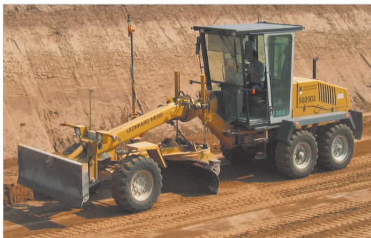
Abb. 3: Grader im Einsatz (Quelle: Leonhard Weiss GmbH & Co. KG)
