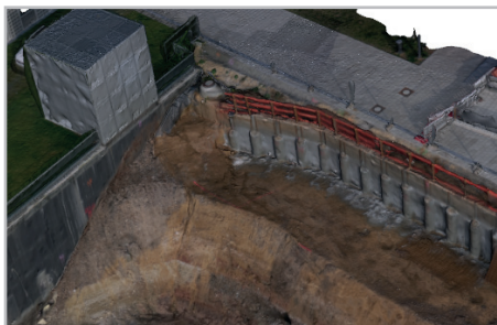
Erfassung einer komplexen Verbau- und Aushubsituation mit einer Drohne © Boll und Partner
