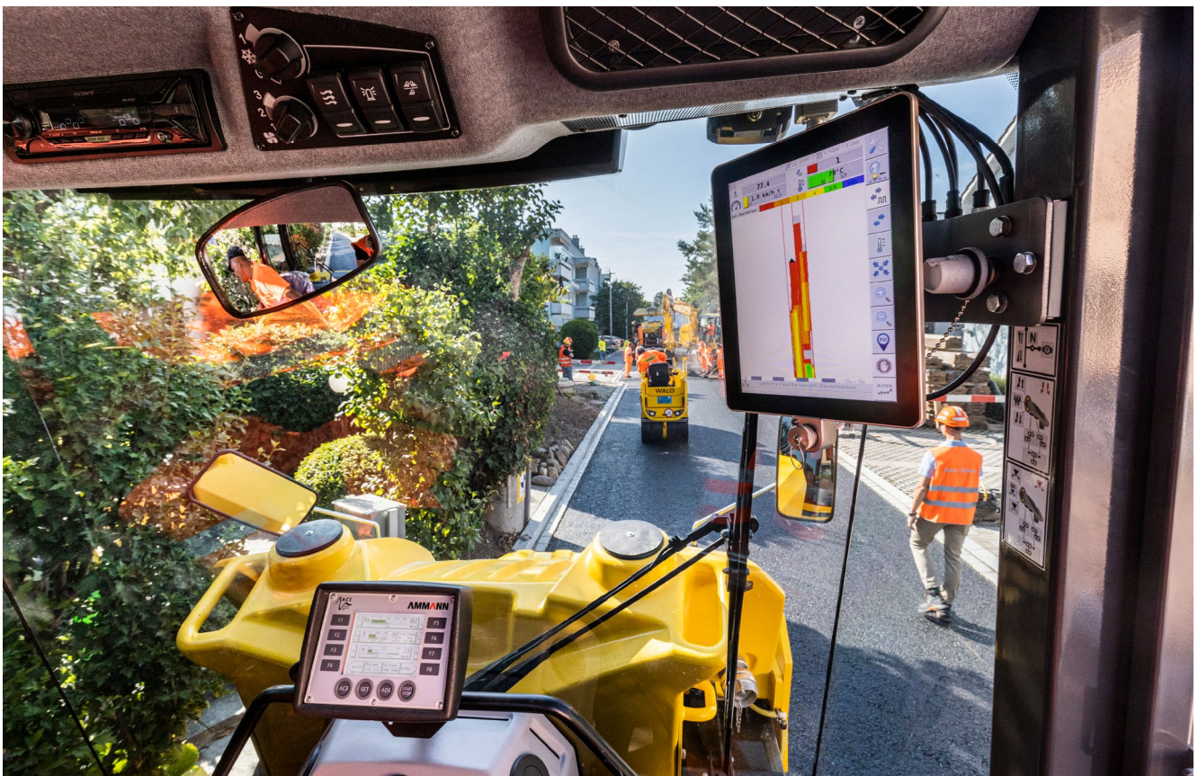
Datenerhebung während des Asphaltierens
