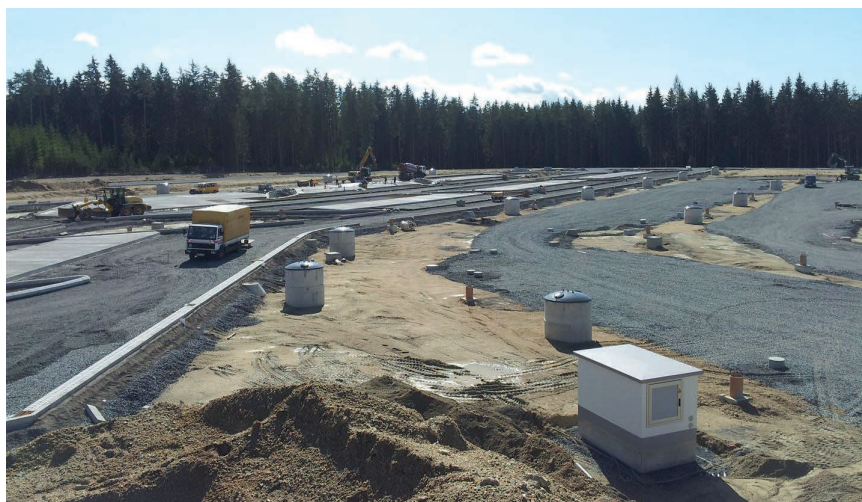
Bauzustand an der Ostseite
