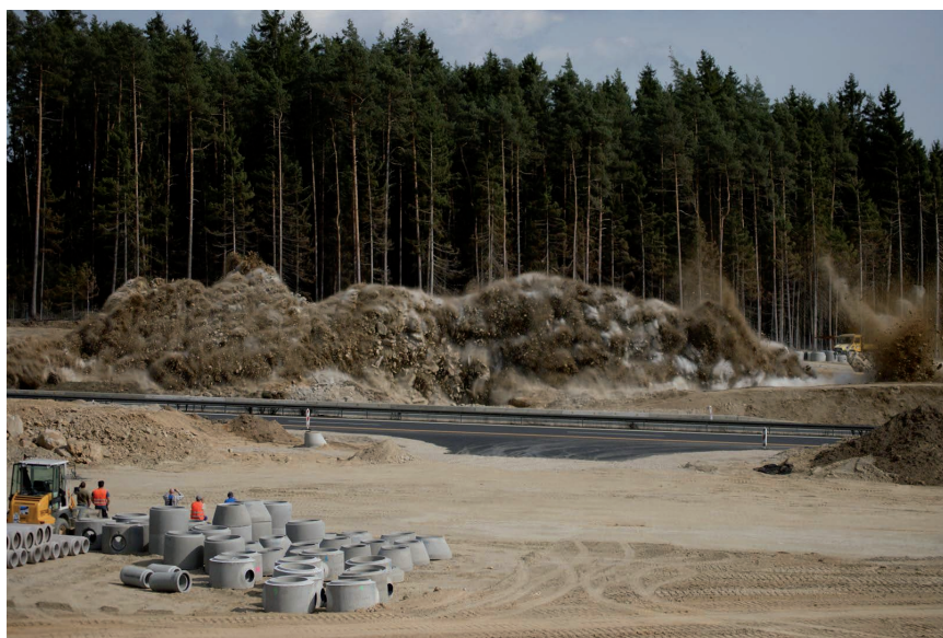
Sprengung an der Autobahn
